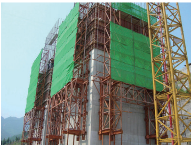
图1 建筑工程框架结构施工
