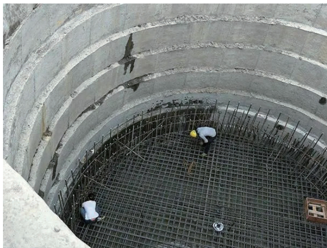
图1 混凝土沉井
