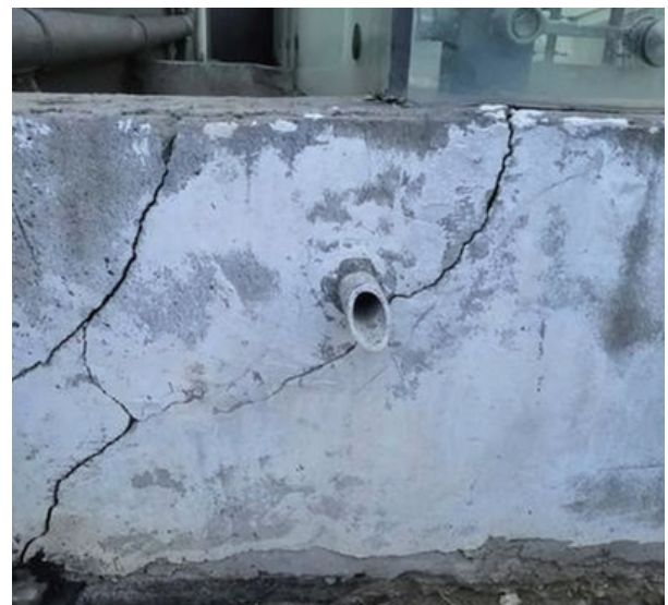
图1 沉降裂缝
