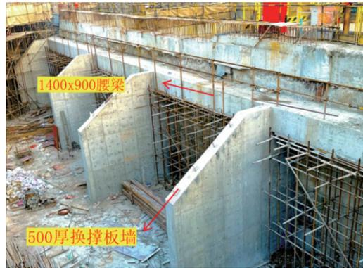
图10：现场换撑板墙施工图
