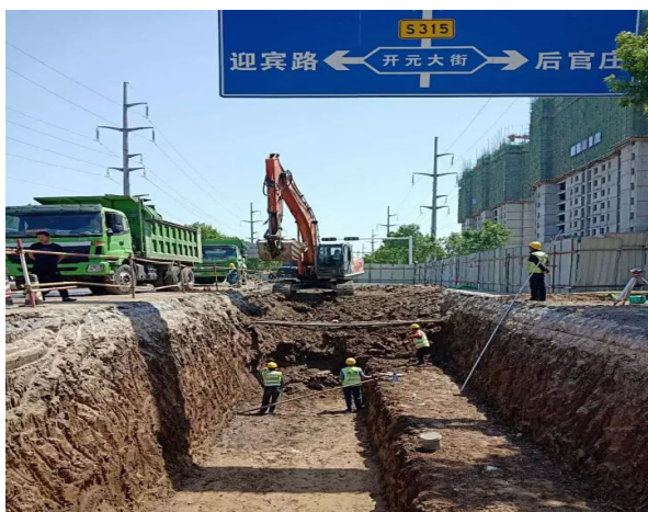
图1 沟槽开挖
