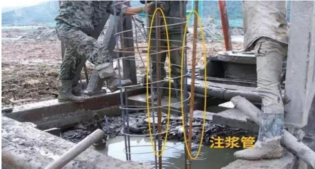
图 1: 某工程管桩基础施工中注浆的施工图
