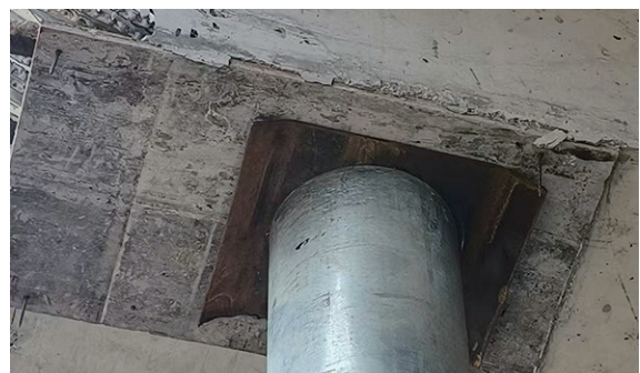
图1 消防管顶部钢板设置效果
