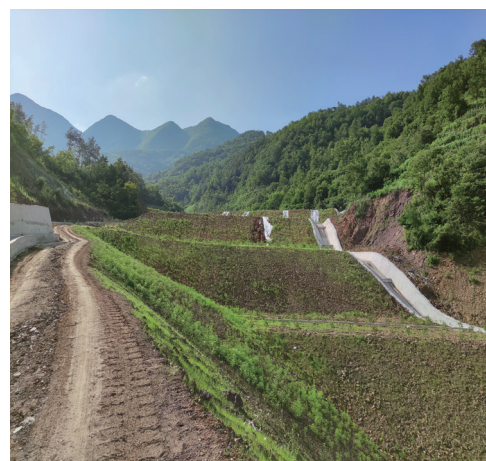
图5 及时对开挖的路堤路堑边坡采取工程及植物防护措施(舒洪涛, 纪金刚/摄影)
