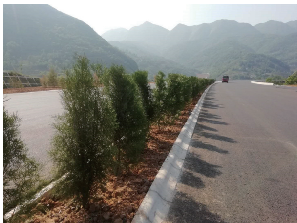
图6 弃渣场、中央分隔带绿化进行专项设计(舒洪涛, 纪金刚/摄影)
