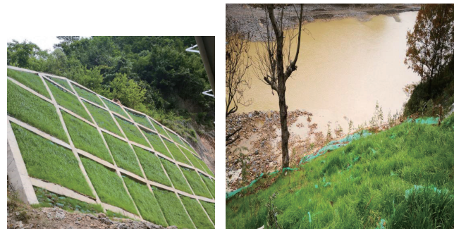
图7 对施工开挖造成的裸露坡面进行植物防护(舒洪涛, 纪金刚/摄影)
