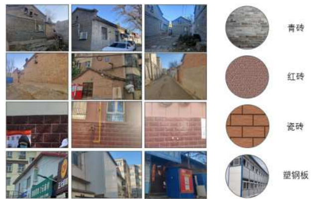
图3 住区建筑状况及使用材料
