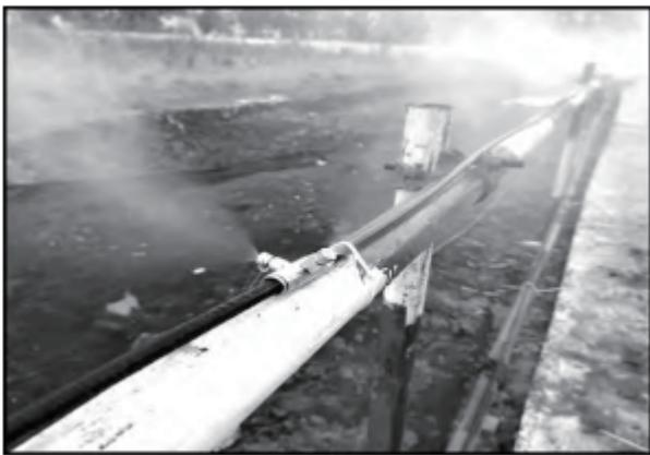
图1 路桥工程采用喷水降尘技术
