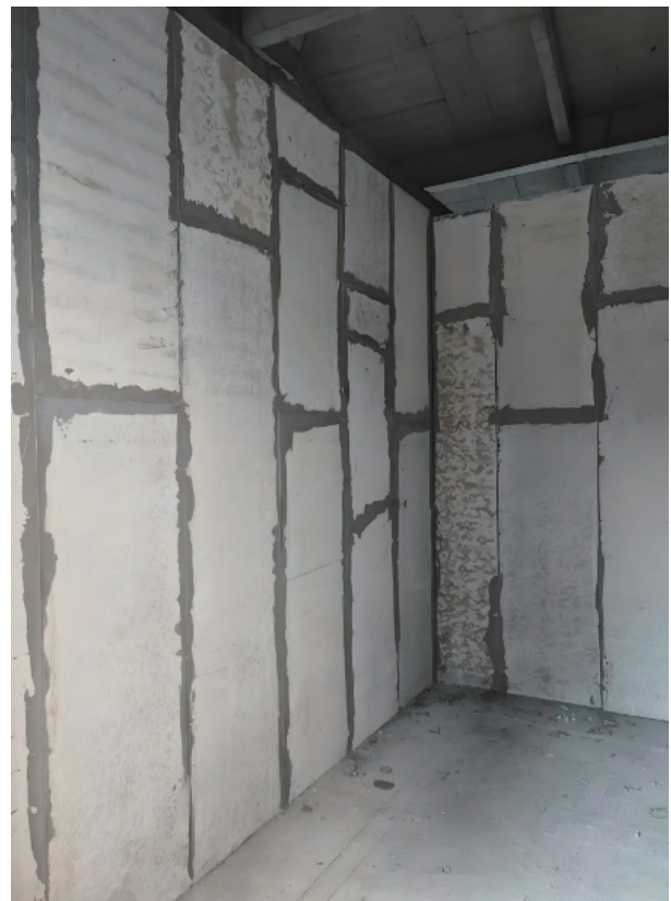
图1：轻质隔墙板施工现场效果示意图
