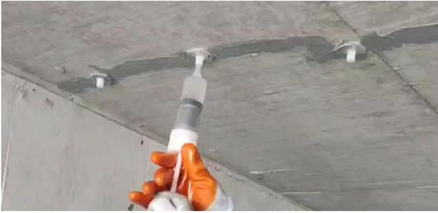
图1 混凝土裂缝注浆修补施工
