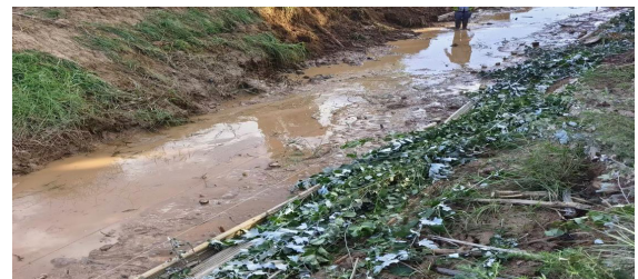
图1 农田水利河道施工
