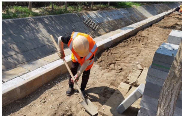
图1 公路工程施工现场
