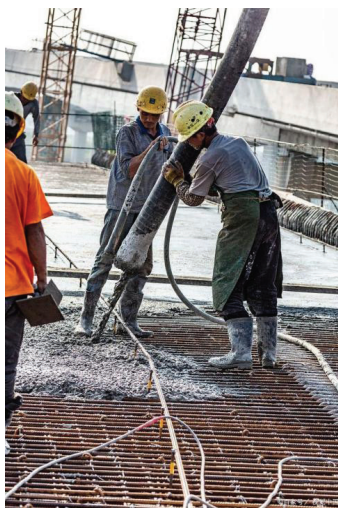
图一 高性能混凝土施工
