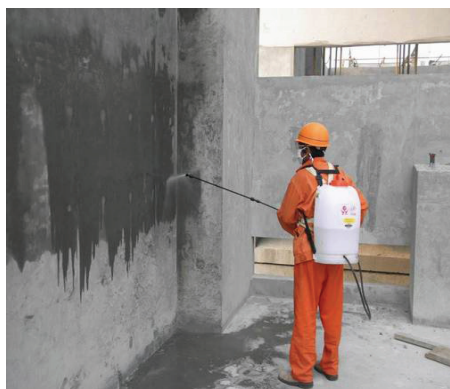
图二 混凝土养护
