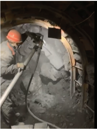
图2 破碎头施工
