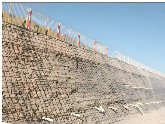
图2 土钉墙支护
