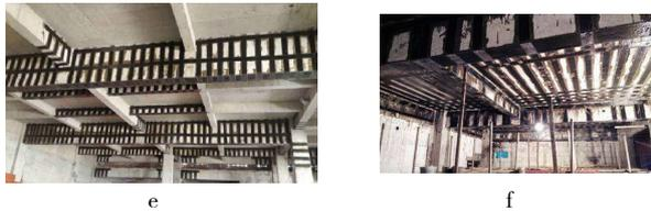
图3 外粘碳纤维材料加固法
