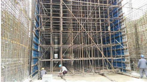
2.4.3 满堂支架整体移动
