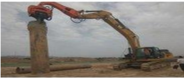
图 1：振动沉桩技术应用过程图示
