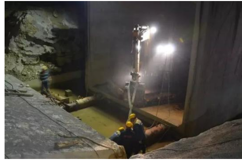
图 7 安装顶镐
