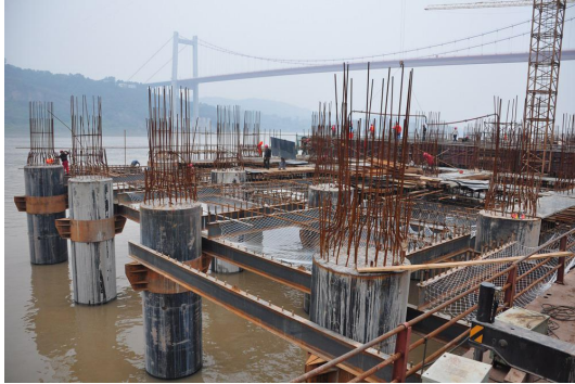
图 12 钢抱箍支撑系统在高桩码头施工中的应用
