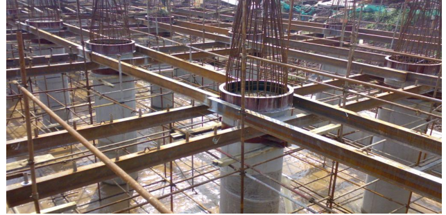
图 5 钢抱箍双向支撑系统现场安装图
