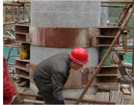
图 9 钢抱箍现场测试与有限元模型
