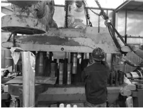
图1 检修人员在起吊的汽缸上卸载倒载螺栓
