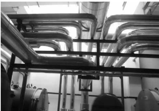
另外,鉴于机房上部空间管道密集,将电力桥架原本的悬吊式桥架变更为了落地托盘式电缆桥架,下方生根使用预埋钢板,再将立柱焊接在钢板上。在水平桥架下采用漏斗技术连接竖直电缆槽到各用电设备旁或配电柜上孔。这样有二大好处:首先,桥架安装方式节省了机房上空空间,更好的让位于供回水等大管道,不再发生冲突问题,同时桥架布置整齐,美观;其次,漏斗技术方法的倾斜面让电缆拥有更大的弯曲空间,让电缆敷设更加流畅。
