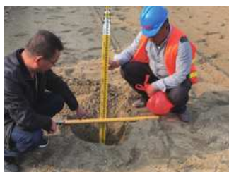
原地面处理翻耕深度检查
