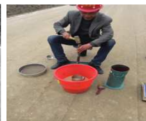
原地面处理压实度检测
