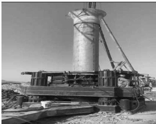
拔桩过程照片
