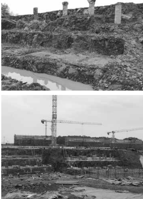
图 3.1 现场土方台阶
