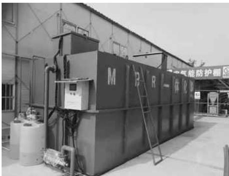
图2-MBR膜工艺一体化污水净化设备现场施工图
