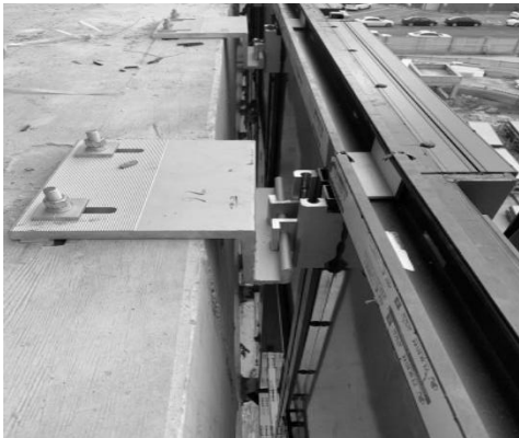
吊装、挂接完毕
