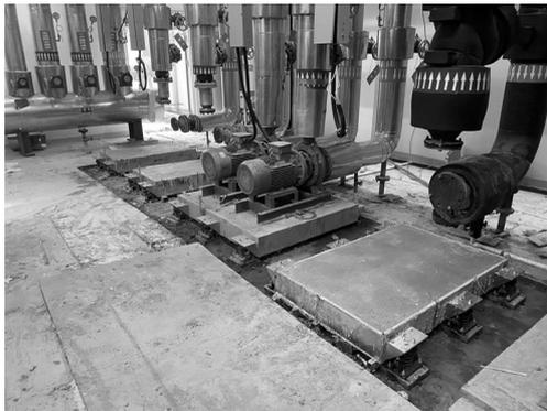
现场水泵减振台座施工
