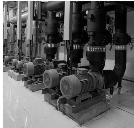
水泵机组采用刚性连接
