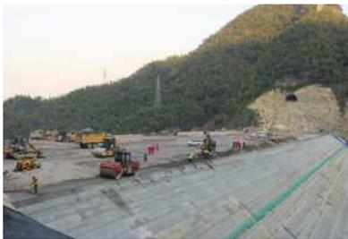
图2 某水利水电工程坝体填筑施工现场
