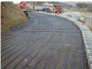
图2 加固加筋法
