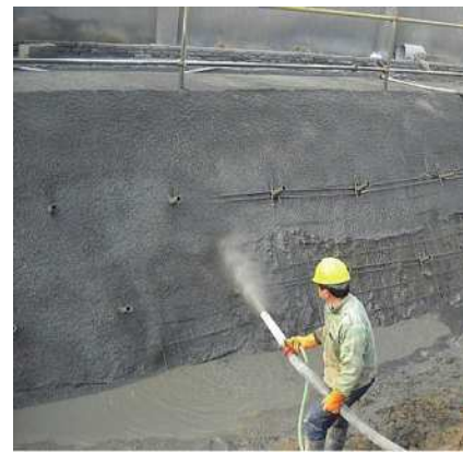
图1 喷绘机喷射混凝土示意图
