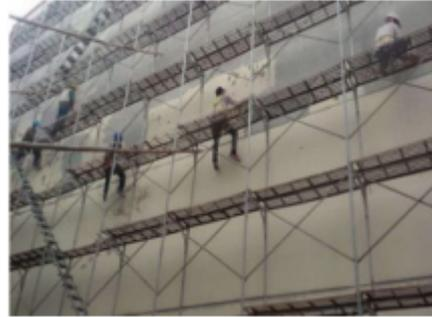
图1 外墙防水施工示意图
