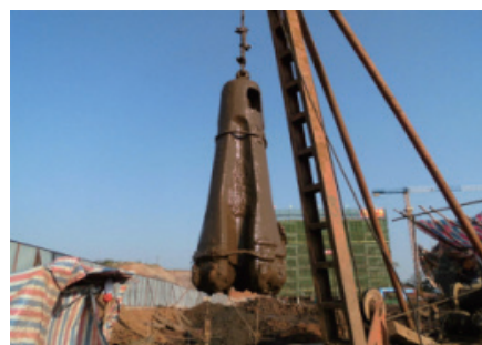
图6 用冲锤将粘性土与水泥冲拌均匀
