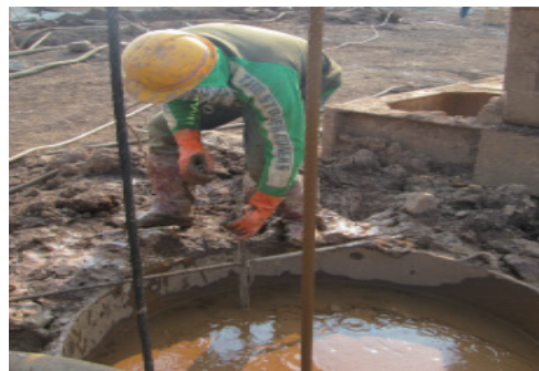
图3 测量冲孔深度
