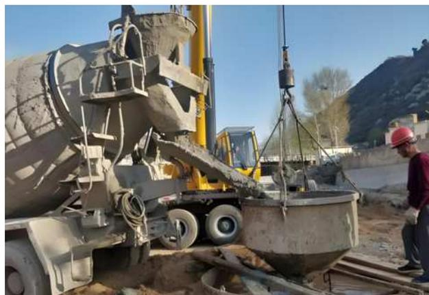
混凝土灌注前,需二次复测沉渣厚度,不符合要求时,需进行二次清孔,直至满足施工需要。导管安装完成后应立即浇筑混凝土,混凝土的塌落度宜为180-220mm,要保证首批混凝土导管的埋深符合要求(不小于1m),首批混凝土的量可根据公式 $V = \pi D^4/4X(H_1+H_2) + \pi d^4 \cdot h_1$ 进行计算确定。水下混凝土的灌注需连续进行,在灌注至距离钢筋笼底部较近位置时,需降低灌注速度,以防止钢筋笼上浮,待灌注至钢筋笼3m以上位置时方可恢复正常灌注速度,在整个灌注过程中要始终保持使护筒的埋深保持在2-6m的深度,并要设置专人计算导管的埋深,以防导管拔出混凝土面造成断桩或夹渣,同时也要避免导管埋置过深,防止拔不出来。
