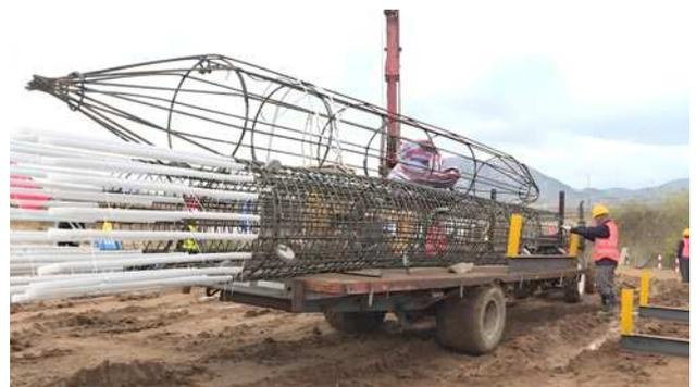
钢筋笼长度 = 桩柱高度 + 钢筋埋置深度 + 钢筋束收头长度, 对于桩基长度较长的钢筋笼, 一般采用分节制作和安装的工艺, 为方便运输, 每节长度不宜超过 20m, 原则上每
