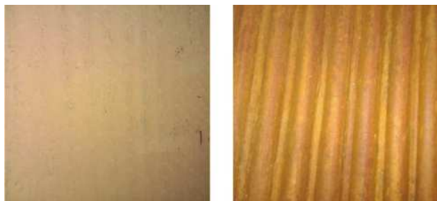
图1 炉膛内水冷壁清洗前后对比图
