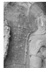
图15 鳞片起翘、剥落
