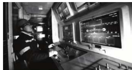
图1 煤矿智能化开采控制室
