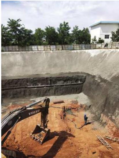
图3 调节池深基坑边坡支护施工现场情况
