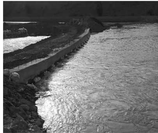
分水口涵管引水现场图
