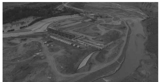
昌吉市水利骨干一期第二标段全期导流围堰现场照片 全期导流围堰从左岸原人工弯道上游 200m 处开始
