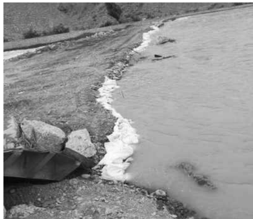
自溃式溢流堰现场图
