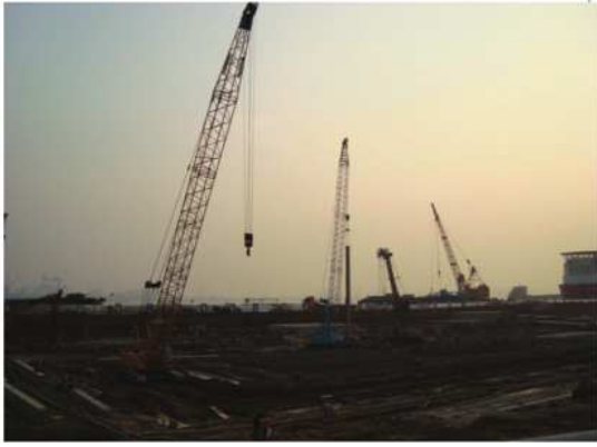
图1 基坑开挖施工图
