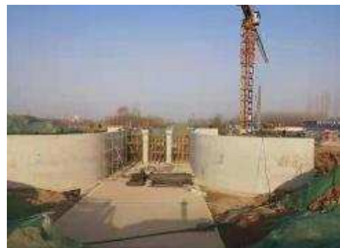
图1 水利施工现场
