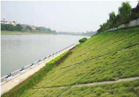
图1 现浇网格生态护坡
