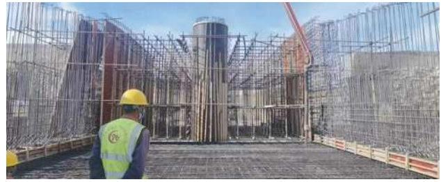
图 2 某地水闸混凝土浇筑施工现场
