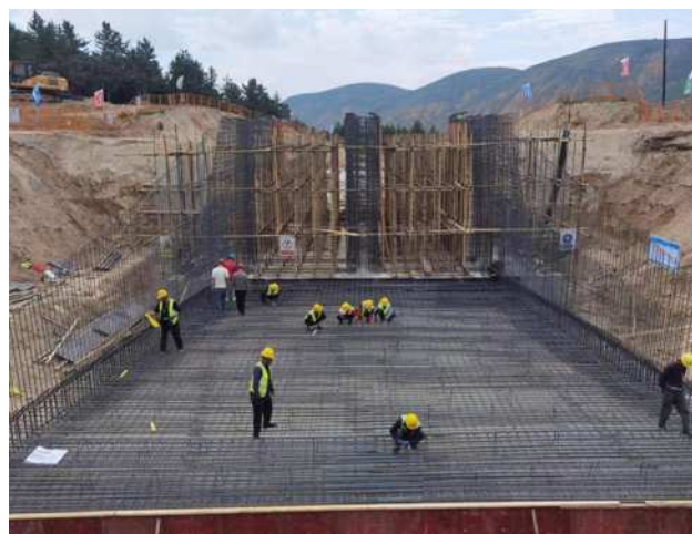
图1 某地水闸施工现场
