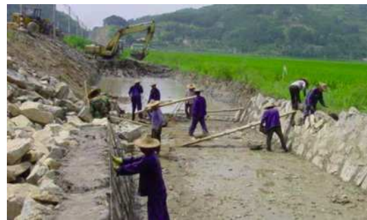
图1 维护农田水利灌溉渠道
