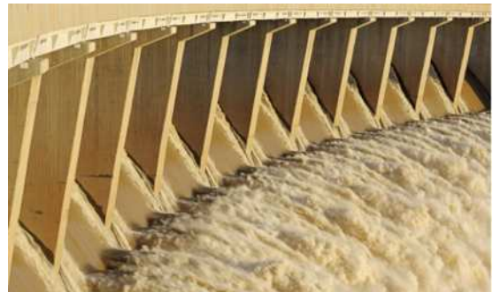
图1 混凝土拦水坝
