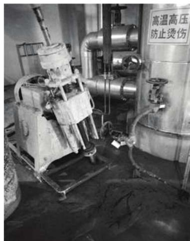
图1 高压喷射灌浆技术施工图
