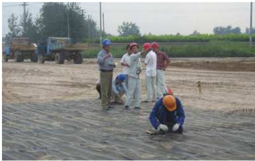
图1 渠道衬砌护坡施工前的砂砾料摊铺
