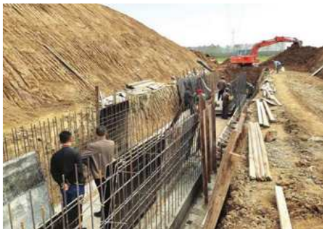
水利工程施工现场
